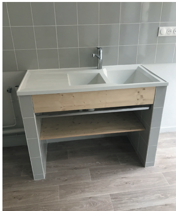
Le meuble sous évier maçonné, une solution sur mesure développée par nos techniciens.
